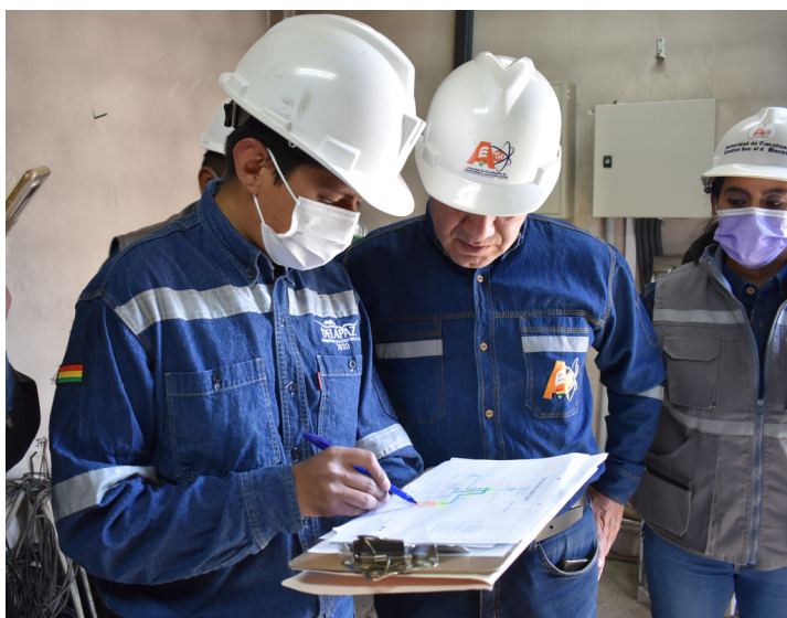
Prueba a equipos de Generación Distribuida, Oficina Central AETN
